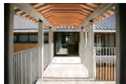
▲役場庁舎2階と連絡橋で接続。柱梁は鉄骨構造、上部の屋根は木造。
