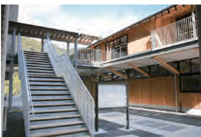
▲役場庁舎2階と連絡橋で接続。柱梁は鉄骨構造、上部の屋根は木造。
